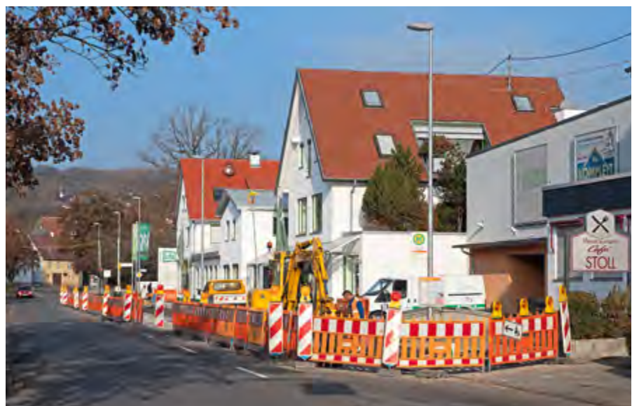
Beispiel für den Glasfaserausbau, hier in Oberensingen in Verbindung mit der Umlegung von Stromleitungen
