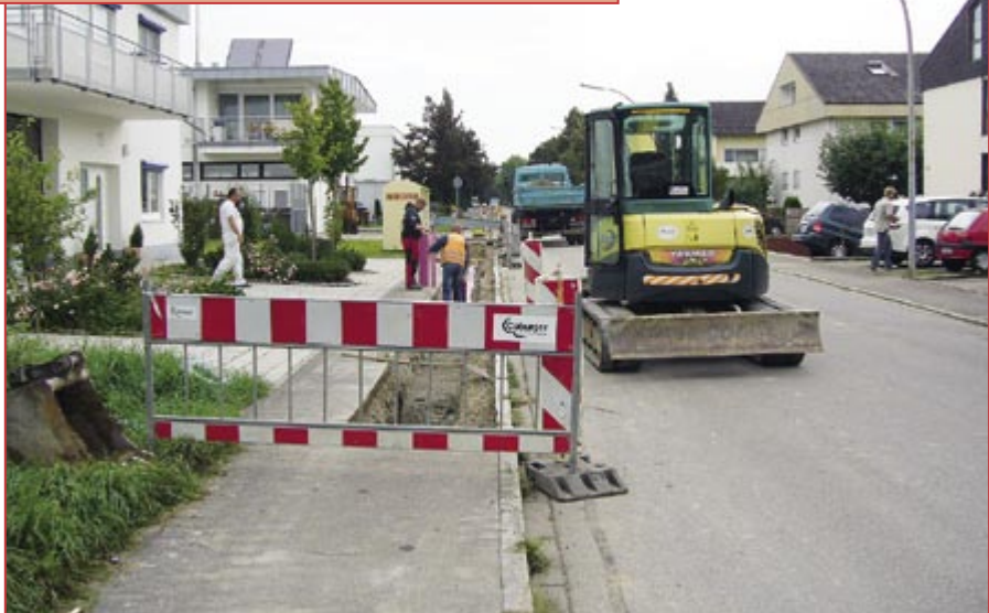
Für den Netzausbau werden im Industriegebiet Zizishausen Kabel verlegt.
