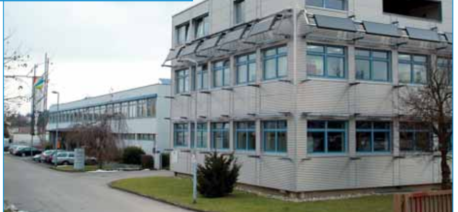
Der städtische Eigenbetrieb Gebäudewirtschaft (GWN) ist in der ehemaligen Kantine der Stadtwerke in der Porschestraße untergebracht. Bilder: Volker Richling
