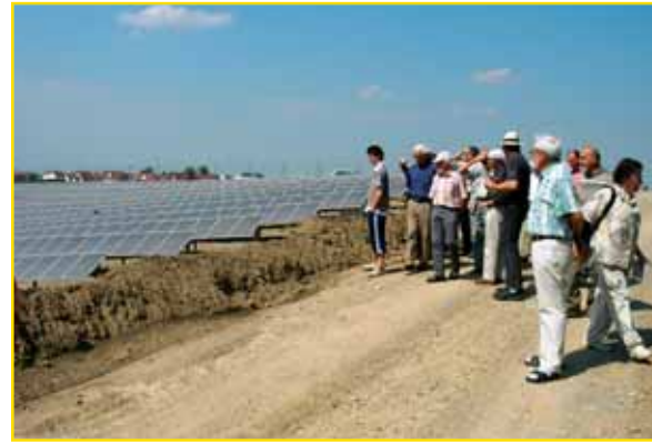
In Baltringen, wo früher Kies abgebaut wurde, erzeugt seit Dezember 2006 eine Freiland-Photovoltaikanlage Strom. Bild: privat
